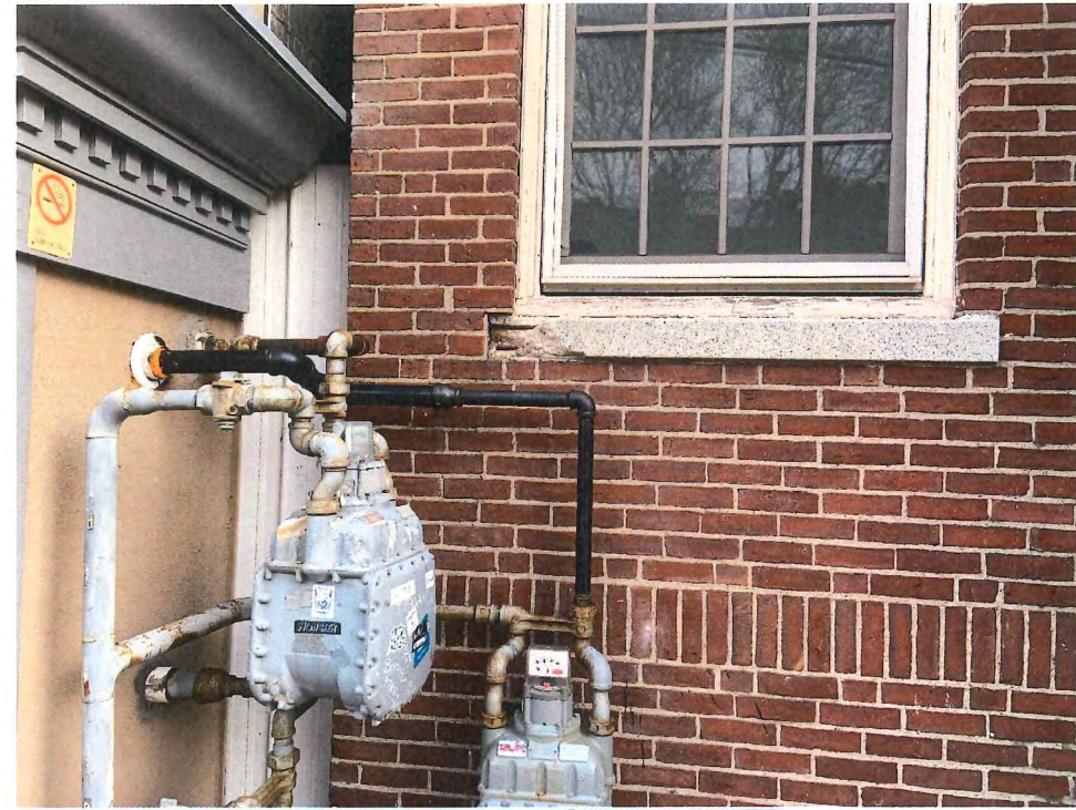
MIDDLE ST., "GAP" TO 'ONE MIDDLE ST.'
