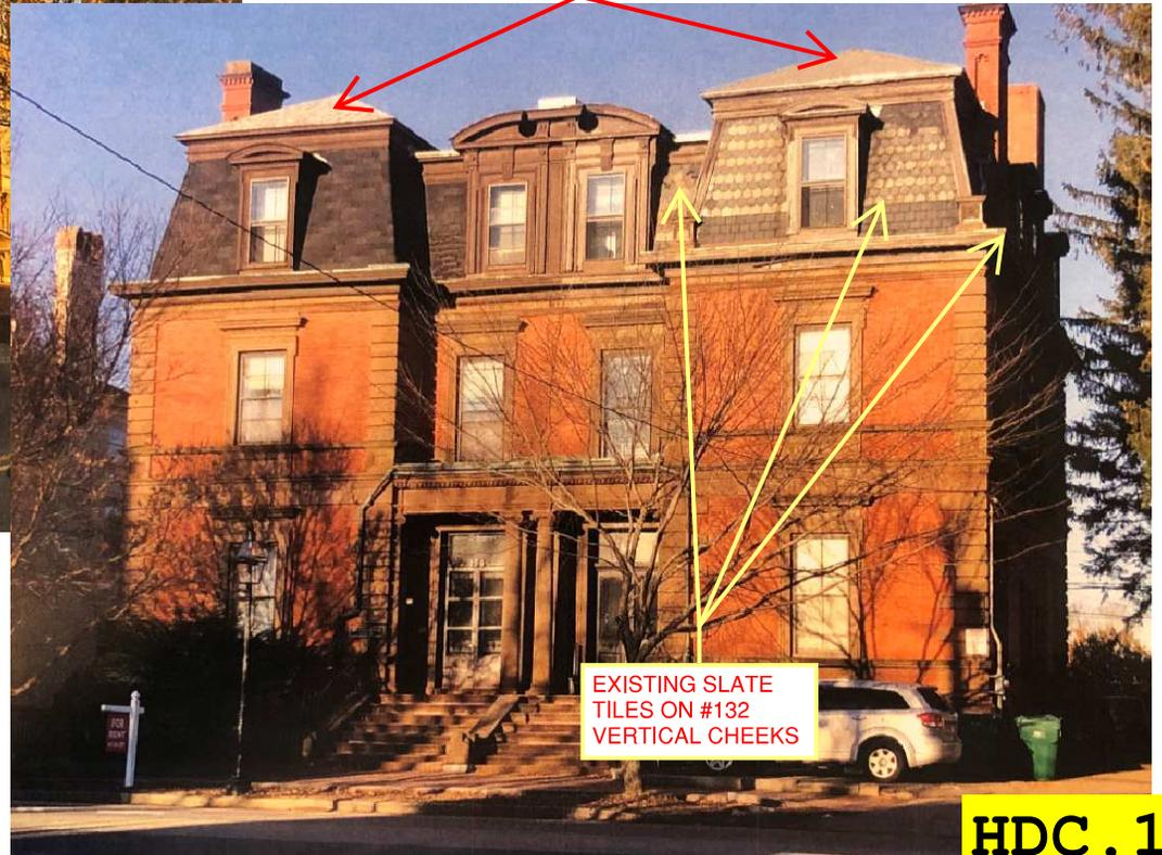
EXISTING ASPHALT SHINGLES ON FRONT CAP ROOFS
