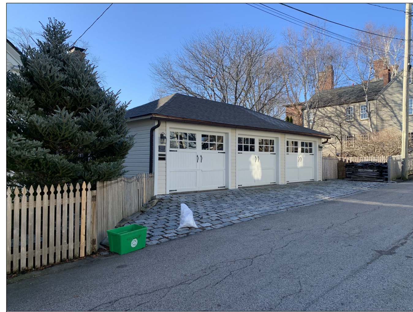
(5): 490 MARCY STREET GARAGE
