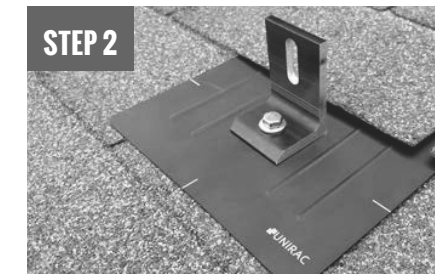
STEP 2 INSTALL L-FOOT
