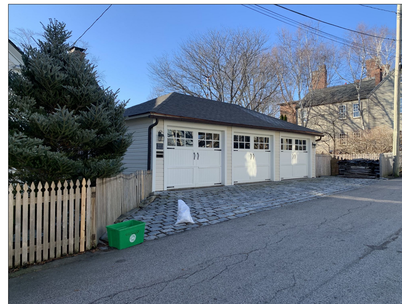
(5): 490 MARCY STREET GARAGE
