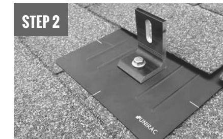
STEP 2 INSTALL L-FOOT
