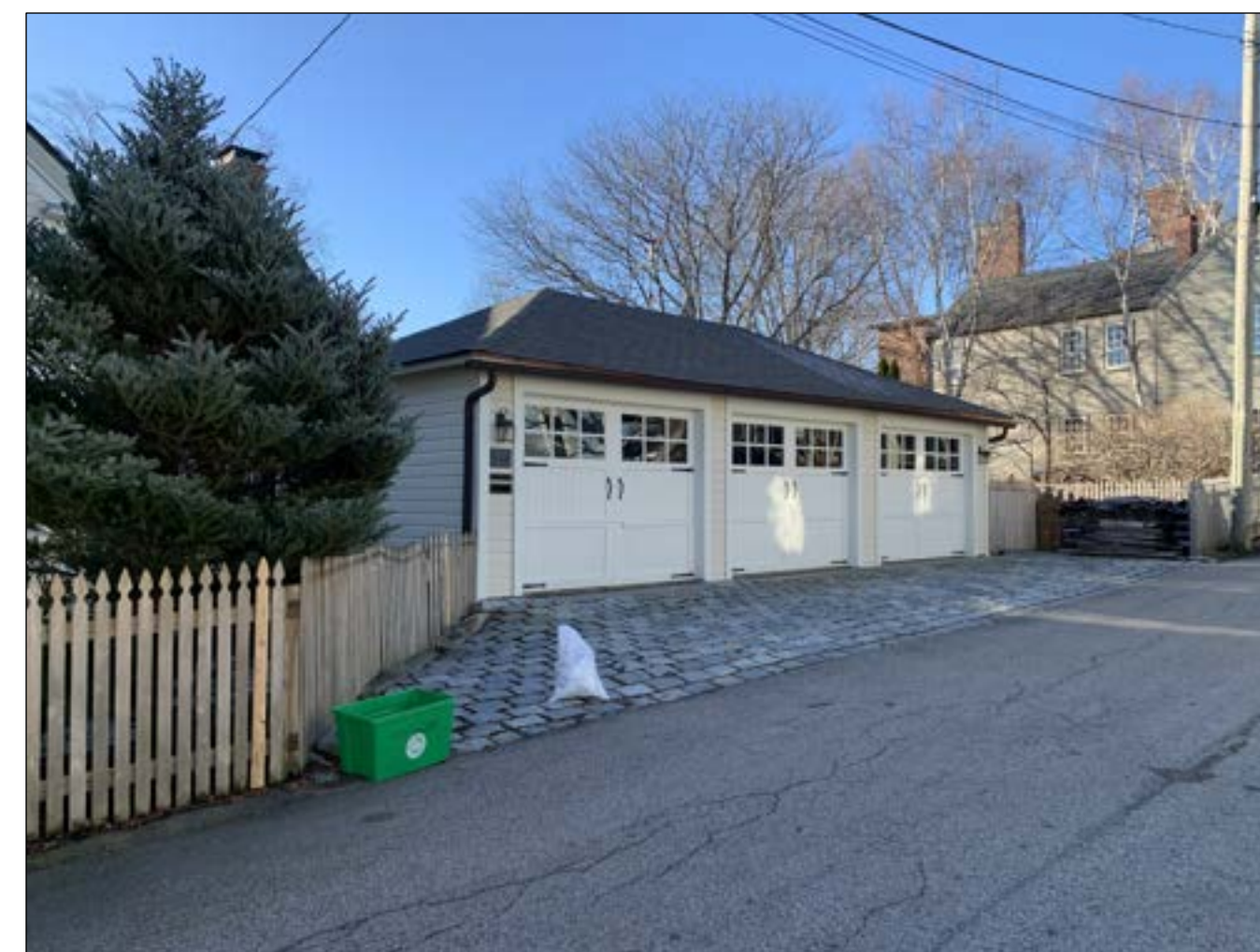
(5): 490 MARCY STREET GARAGE
