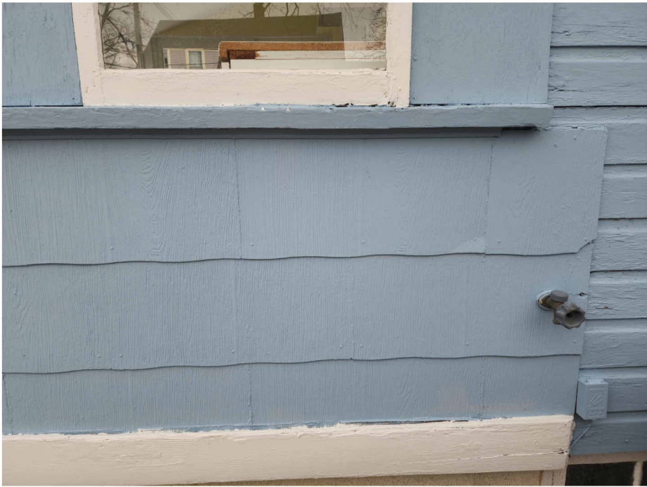
ASBESTOS SIDING
