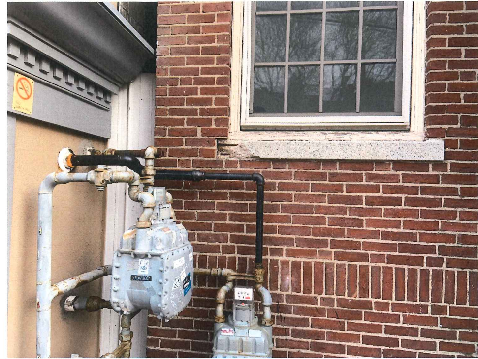
MIDDLE ST., "GAP" TO 'ONE MIDDLE ST.'
