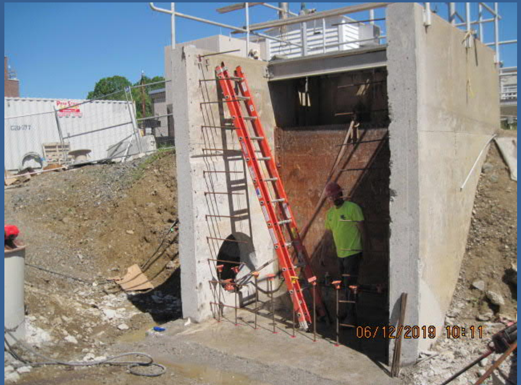
Effluent Distribution Box
